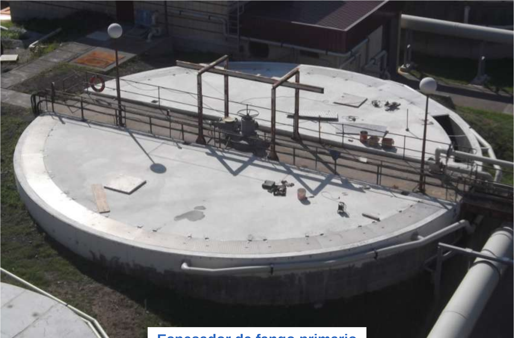
Espesador de fango primario
